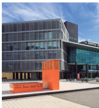
Park Technologiczny Andaluza. Budynek biurowy o wysokiej efektywności energetycznej. Hiszpania. ECOi
