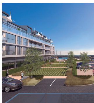
Marina Village Greystones. 205 mieszkań i 153 domy. Irlandia. Aquarea
